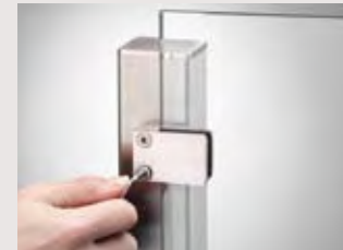
Holzplatten entfernen und Glas an Pfosten montieren.
